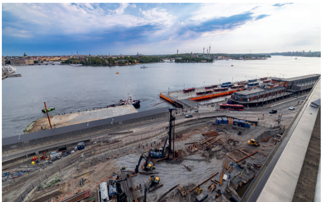
2. De runda orange ringar som syns utmed vägbanan en bit in i grundläggningen, är toppen av de stålplåtar – totalt 677 stycken – som man pålar och stabiliserar marken med. Pålarna, man ser dem ligga längst ner i bilden bredvid den maskin som slår ner dem i marken, ska bära upp både själva överdäckningen, samt husen som kommer att byggas ovanpå den – bland annat Nobelcenter.
