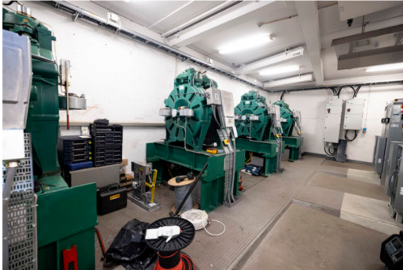
Maskinrummet ligger ovanför hisschaktet. Hissens hjärna finns i de silverfärgade apparatskåpen till höger och hissens hjärta i maskinen som sitter på de gröna drivskivorna.
